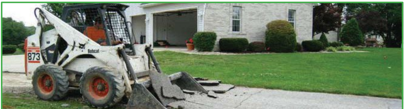
Usando un excavador para remover pavimento
